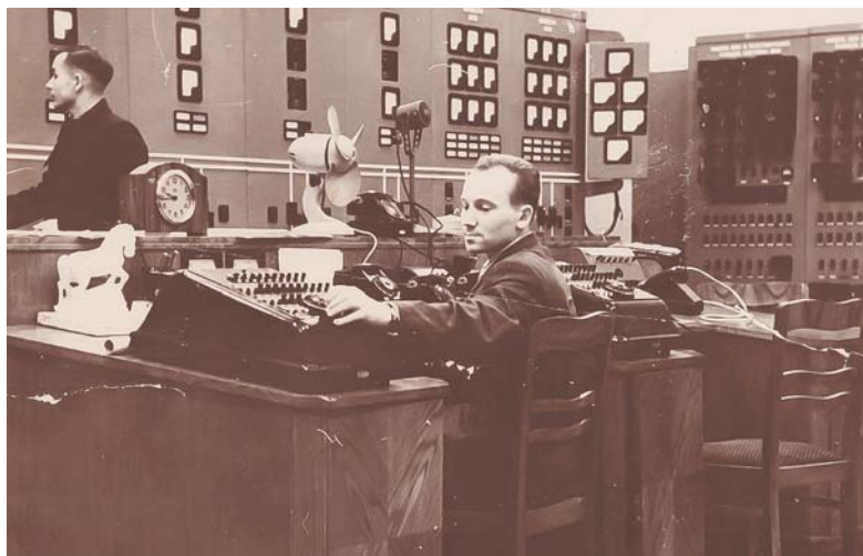
За пультом управления установки 400 кВ дежурный инженер Борисанов Я. И., 1958 год
