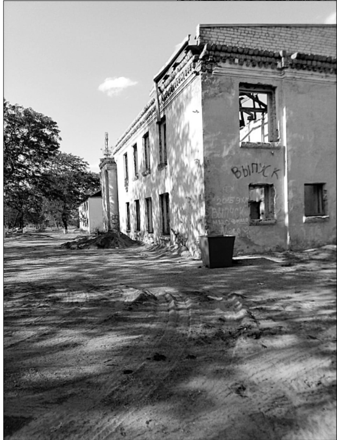
↑ Руины бывшей электростанции ← и Дома культуры в посёлке Ставропольский
