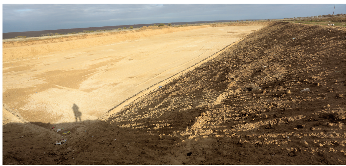
Ложе нового полигона для утилизации твердых коммунальных отходов
