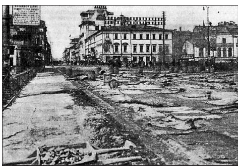
Реконструкция мостовой. 1928 год.
