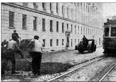
Укладка асфальтовой мостовой на Никитском бульваре.
