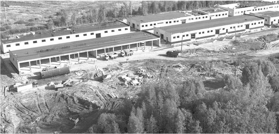
На фото с сайта http://zebra-to.ru – объект незаконной реконструкции.
