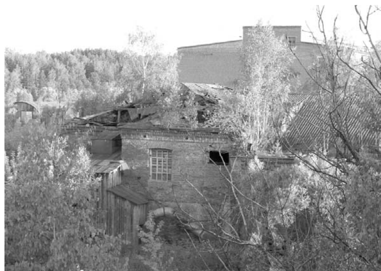
Здание разрушенного текстильного комбината
