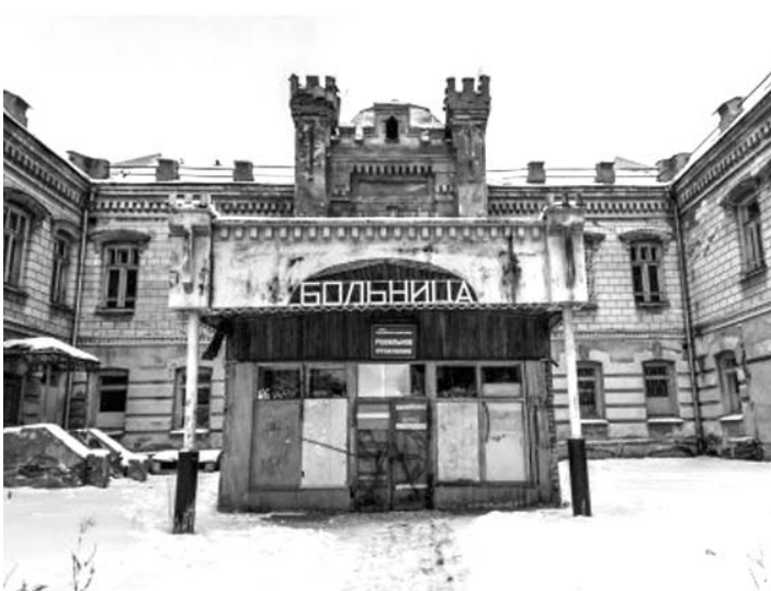
Здание роддома в г. Покров заброшено уже долгие годы.
