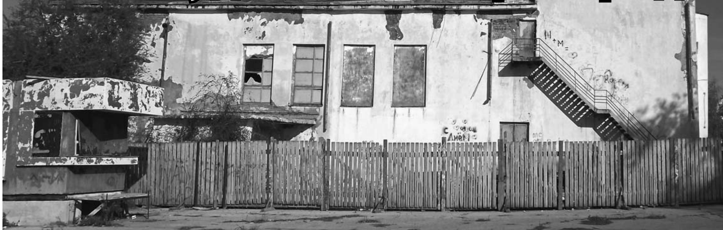
Ремонт ДК «Сатурн» в пос. Береза временно остановлен
