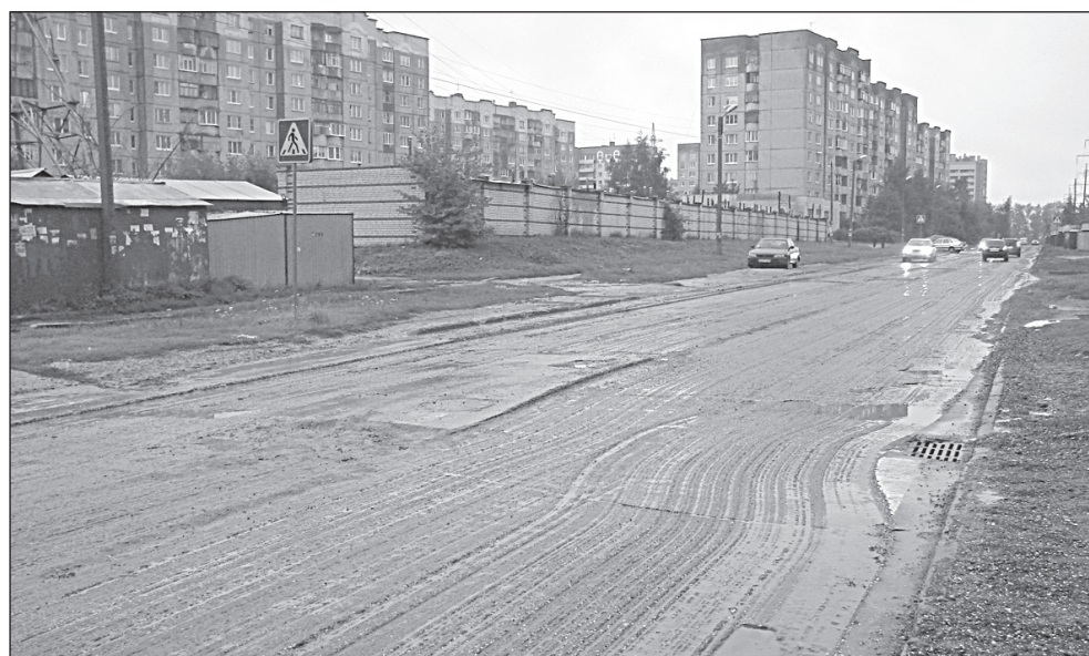
А дорогу на улице Соколова-Соколенка вообще в дождь ремонтировали.
